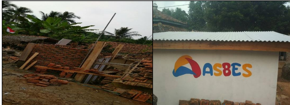
Gambar 1. Pelaksanaan pembangunan MCK.
