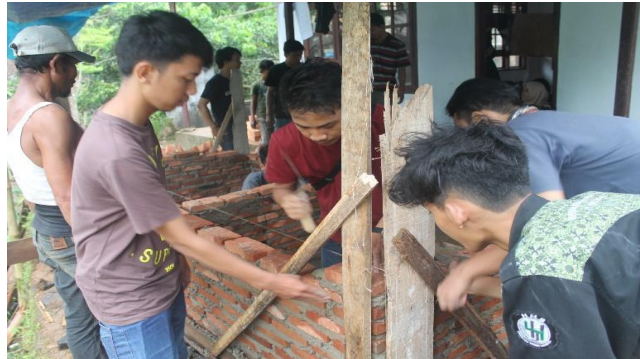
Gambar 3. Pelaksanaan pembangunan MCK komunal.
