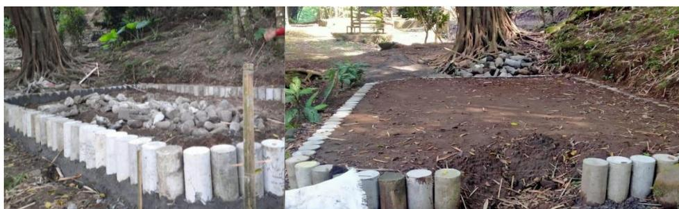
**Gambar 7.** Konstruksi panggung dengan silinder beton.
