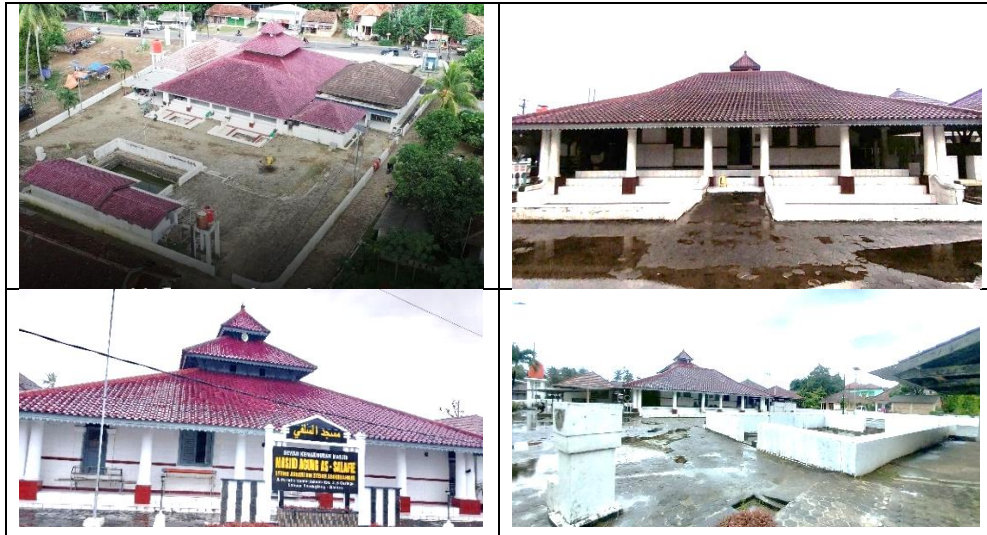
Gambar 1. Kondisi eksisting Masjid Caringin pada bulan Maret 2024.
