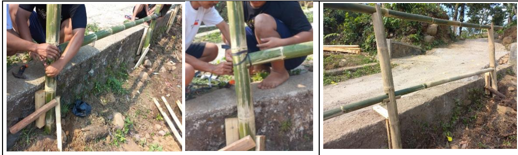
Gambar 14. Proses Pemasangan Hand Railing Bambu
