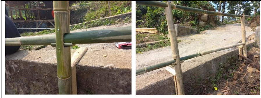
Gambar 10. Sambungan Plugin pada Hand Railing
