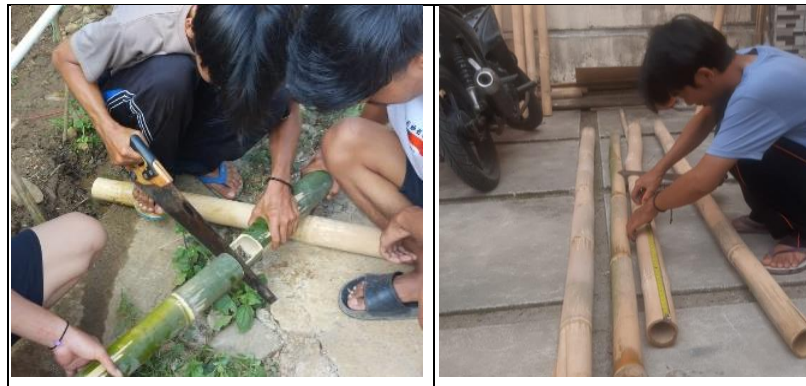
Gambar 12. Proses Pengukuran dan Pemotongan
