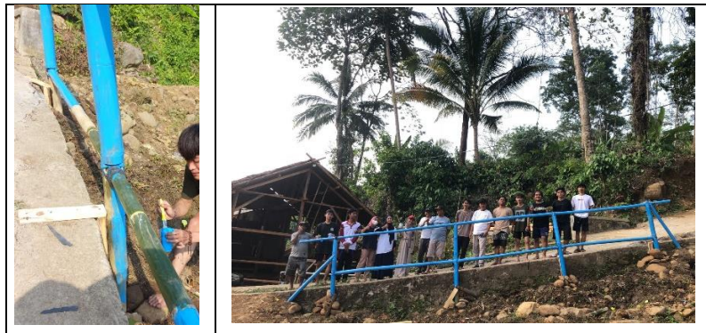
Gambar 15. Proses Pemasangan Hand Railing Bambu
