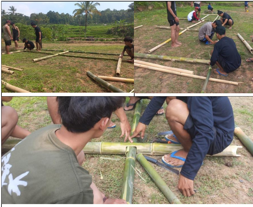
Gambar 13. Proses Penyusunan Dan Perakitan Bambu
