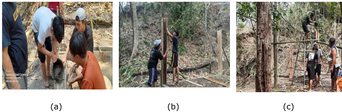
Gambar 10. (a) Pengecoran sloof (b) Bekisting besi kolom (c) Pengecoran kolom
