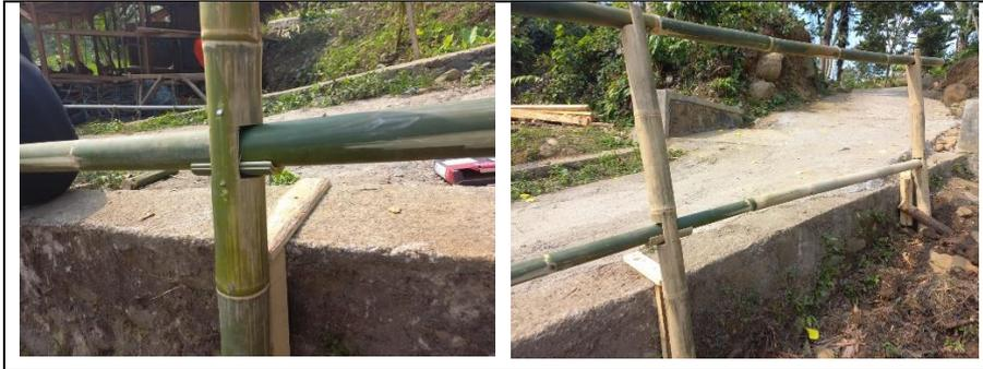
**Gambar 10.** Sambungan Plugin pada *Hand Railing*
