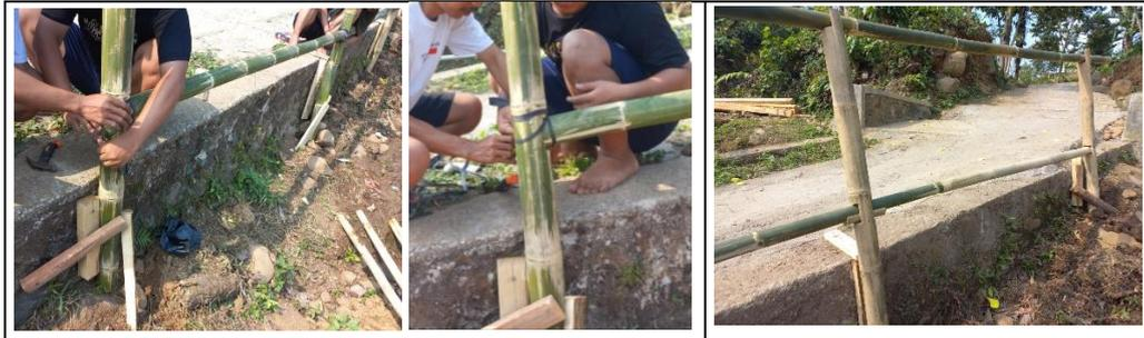
**Gambar 14.** Proses Pemasangan *Hand Railing* Bambu
