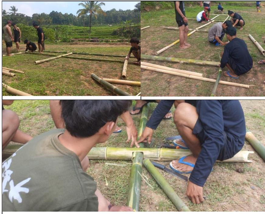
**Gambar 13.** Proses Penyusunan Dan Perakitan Bambu
