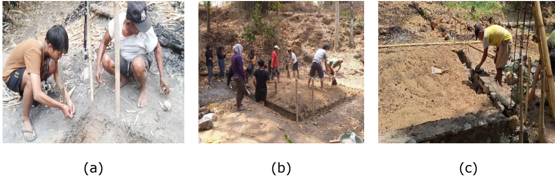
Gambar 9. (a) Kegiatan Levelling (b) Galian Fondasi (c) Pembuatan Fondasi
