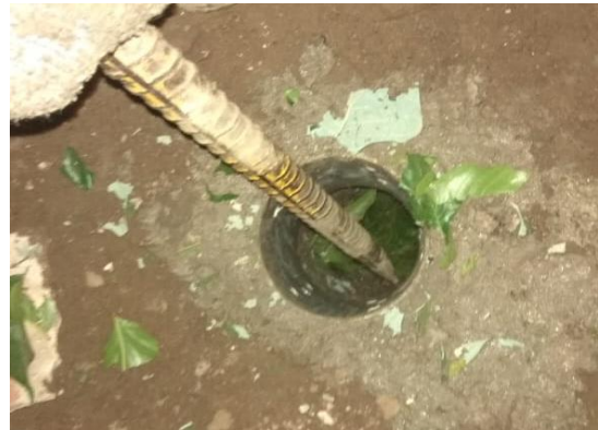
Gambar 4. Pembuatan Lubang Biopori
