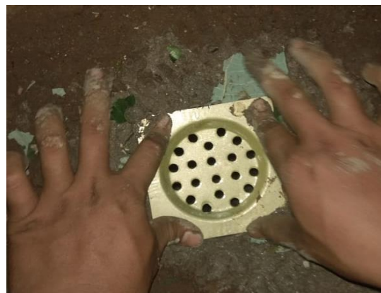
Gambar 5. Memasang penutup lubang biopori
