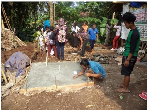
(b) Penutup Sumur Resapan
