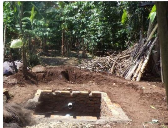
(b) Pasangan Bata dengan Pipa *Inlet* dan *Outlet*
