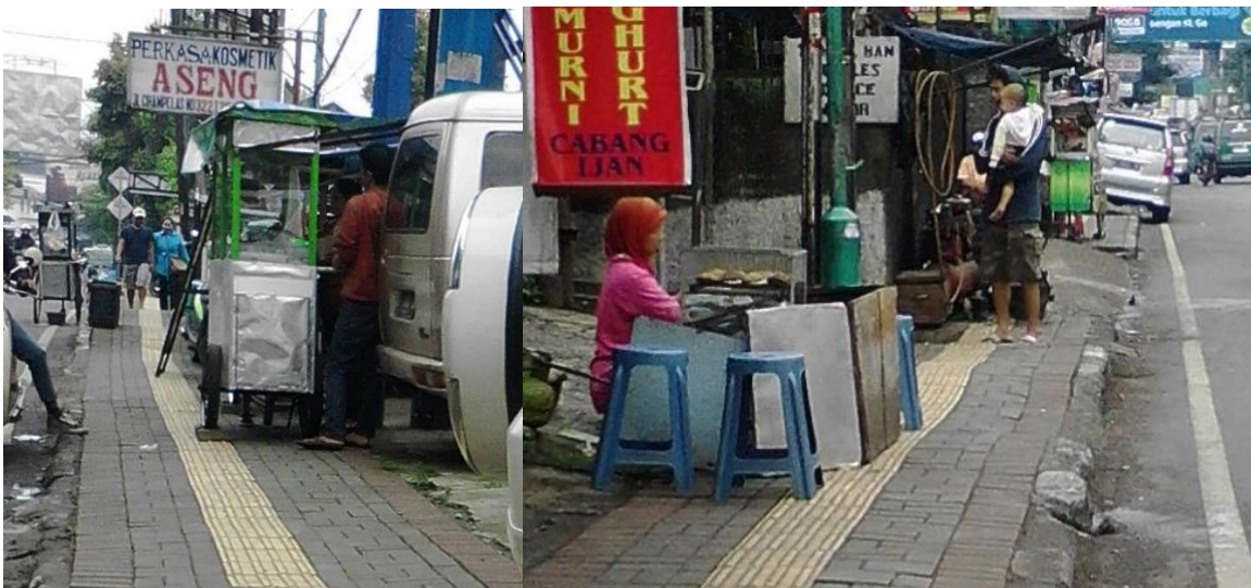
Gambar Kondisi Trotoar Jalan Cihampelas
