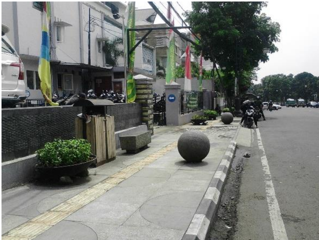
Gambar Kondisi Trotoar Jalan RE Martadinata
