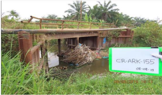
Gambar 2. Tampak Jembatan CR-ARK 155
