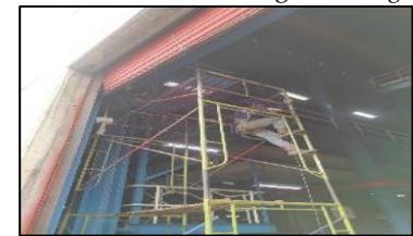
Gambar 2. Proses Pemasangan Rolling door 2
