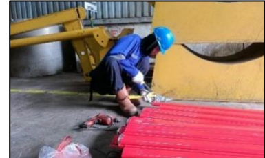
Gambar 1. Proses Pemasangan Rolling door 1
