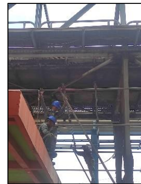
Gambar 5. Proses Pemasangan Kabel Conveyor 3
