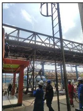
Gambar 3. Proses Pemasangan Kabel Conveyor 1
