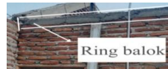
Gambar 24. Ring balok Perumahan P3 Sumber : Dokumentasi Penulis, 2021
