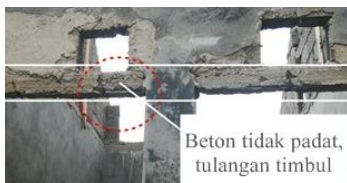
Gambar 19. Balok lintel Perumahan P2 Sumber : Dokumentasi Penulis, 2021
