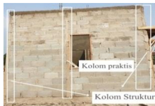
Gambar 26. Dinding Perumahan P1 Sumber : Dokumentasi Penulis, 2021
