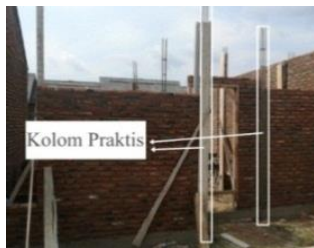
Gambar 28. Dinding Perumahan P3 Sumber : Dokumentasi Penulis, 2021
