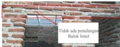
Gambar 20. Balok lintel Perumahan P3 Sumber : Dokumentasi Penulis, 2021
