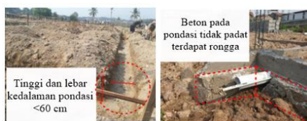
Gambar 6. Pondasi batu kali Perumahan P1 dengan galian
