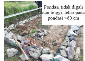
Gambar 8. Pondasi batu kali Perumahan P3 tanpa galian
