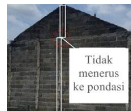
Gambar 30. Kolom praktis pada gunungan Perumahan P2
