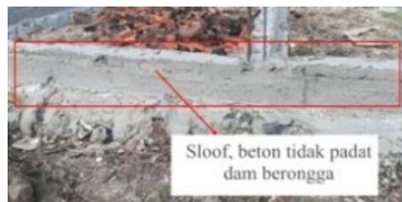
Gambar 12. Sloof Perumahan P3 Sumber : Dokumentasi Penulis, 2021
