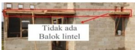
Gambar 18. Balok lintel Perumahan P1 Sumber : Dokumentasi Penulis, 2021
