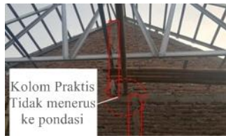
Gambar 31. Kolom praktis pada gunung Perumahan P3
