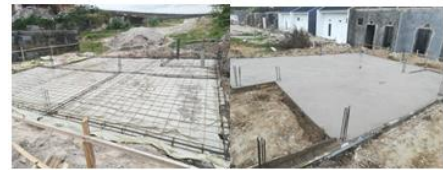
Gambar 7. Pondasi pelat beton bertulang Perumahan P2
