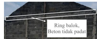
Gambar 23. Ring balok Perumahan P2 Sumber : Dokumentasi Penulis, 2021
