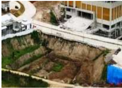
Gambar 1 Kondisi Lereng Penelitian Sumber : Data Penulis, 2021
