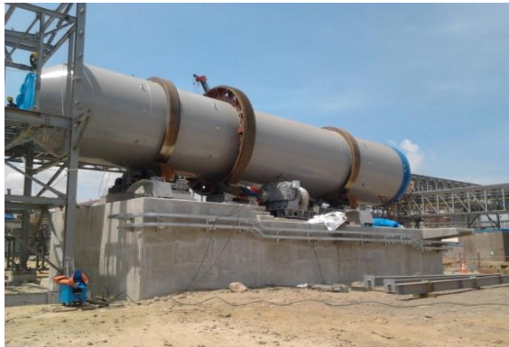
Gambar1. Mesin Mixing Drum pada proyek Krakatau Posco Cilegon
