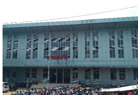
Gambar 2. Stasiun maja (Sumber : Dokumentasi Penulis, 2019)
