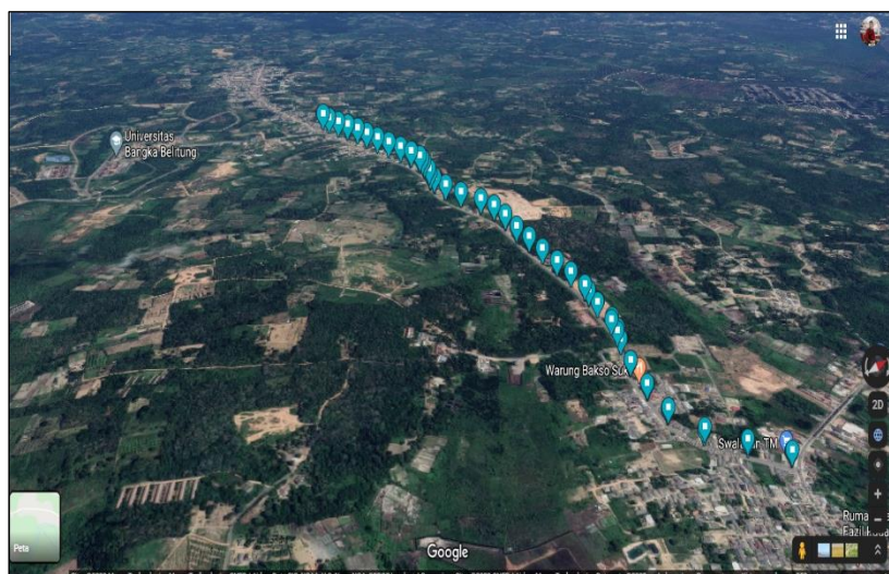
Gambar 1. Lokasi pemasangan penerangan jalan umum berbasis tenaga surya [14]
