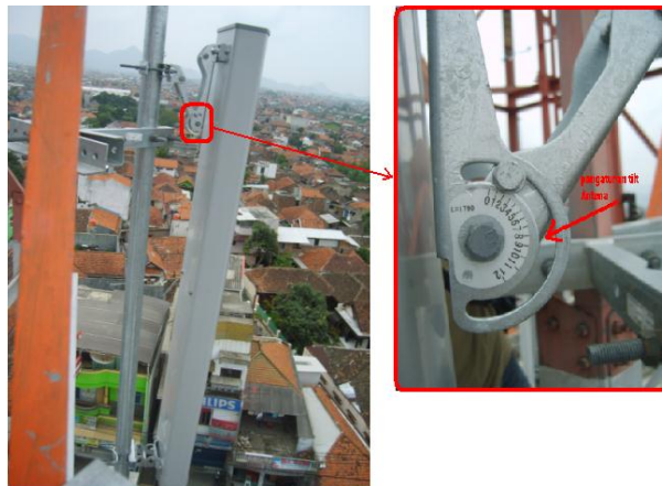
Gambar 5. Pengaturan pengukuran kemiringan antenna
