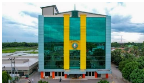
Gambar 1 Bangunan Gedung Rumah Sakit Hermina
