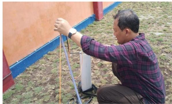
Gambar 5. Instalasi sensor level air tanah.
