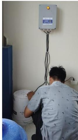
Gambar 8. Instalasi sistem pemantauan konsentrasi gas radon di sebuah ruangan Kantor BPBD Klaten
