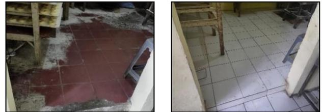
Gambar 13. Perbaikan pada lantai; (a) sebelum perbaikan, (b) sesudah perbaikan
