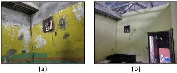
Gambar 11. Perbaikan pada ventilasi udara; (a) sebelum perbaikan, (b) setelah perbaikan
