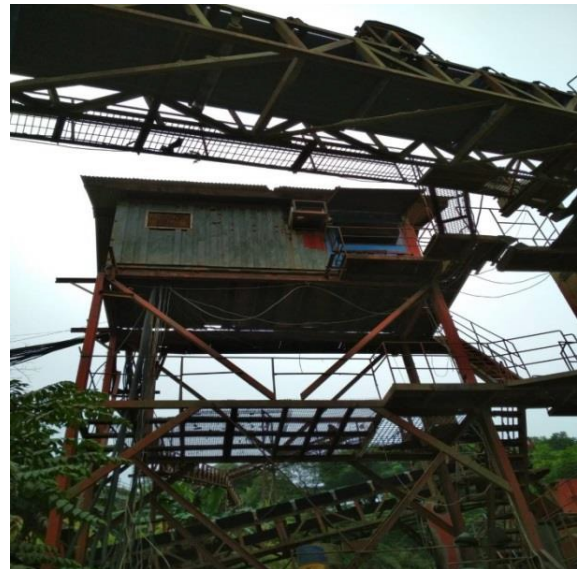
Gambar 1. Kondisi lapangan plant A2
