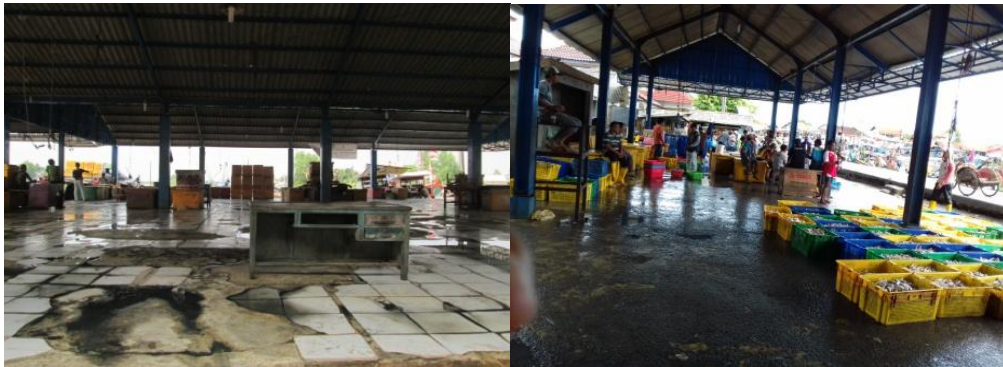
Gambar 3. Lantai gedung TPI (kiri) dan lantai pengepakan (kanan).
