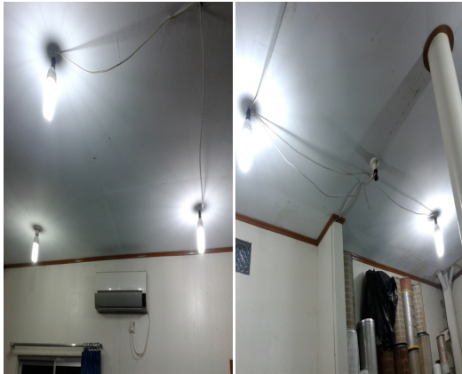
Gambar 7. Kondisi penempatan lampu setelah perbaikan
