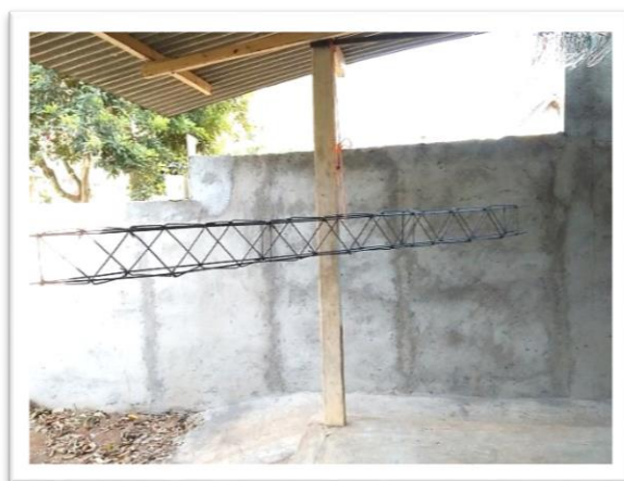
Gambar 1. Ide penemuan begel model rangka saling-silang
