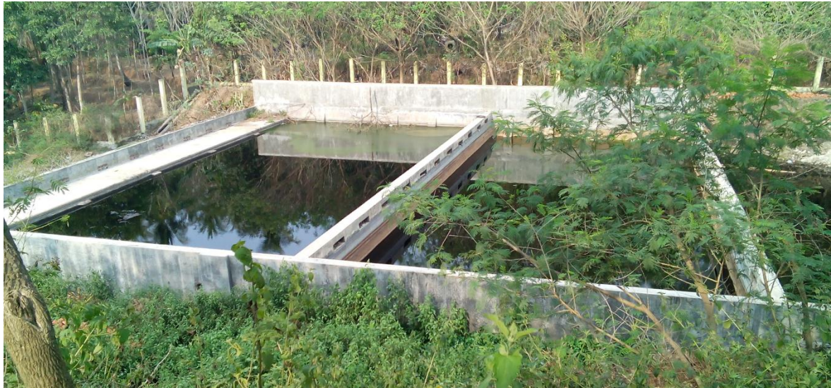
Gambar 3. Bak penampung air lindi di TPSA Bagendung.
