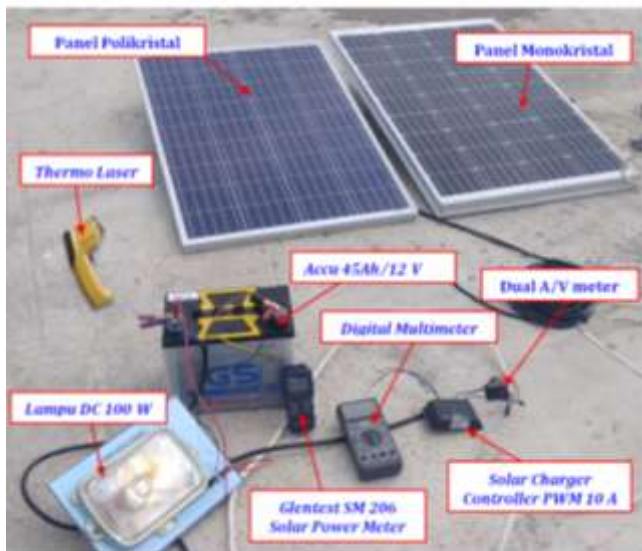
Gambar 2. Instalasi peralatan pengujian panel surya
